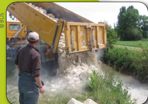
Recharge en granulats de la Dive
