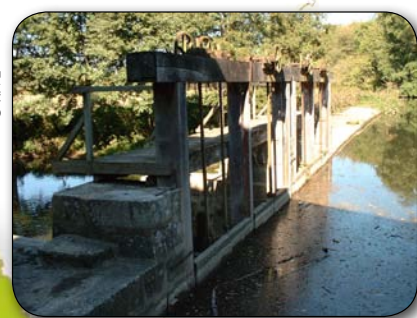
Barrage du moulin du Désert vu de l'amont
