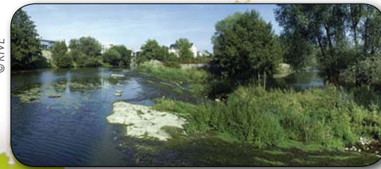
Barrage de la Gaudinière vu de l'amont
