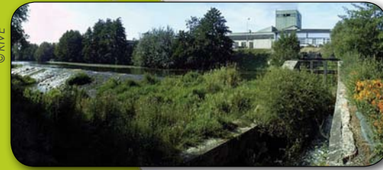
Barrage de la Gaudinière vu de l'aval
