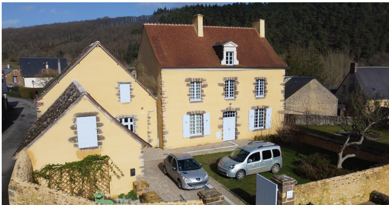
- Le siège du Syndicat du Bassin de la Sarthe à Saint-Léonard-des-Bois (72) -
