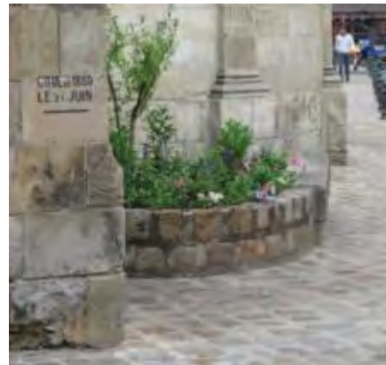
Repère de la crue de juin 1889 sur l'église de la Ferté-Bernard (Direction départementale de l'Équipement de la Sarthe)
