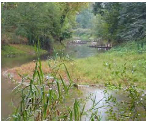
Travaux de restauration de la Vaige, épis en bois diversifiant les écoulements (IIBS, 2015)
